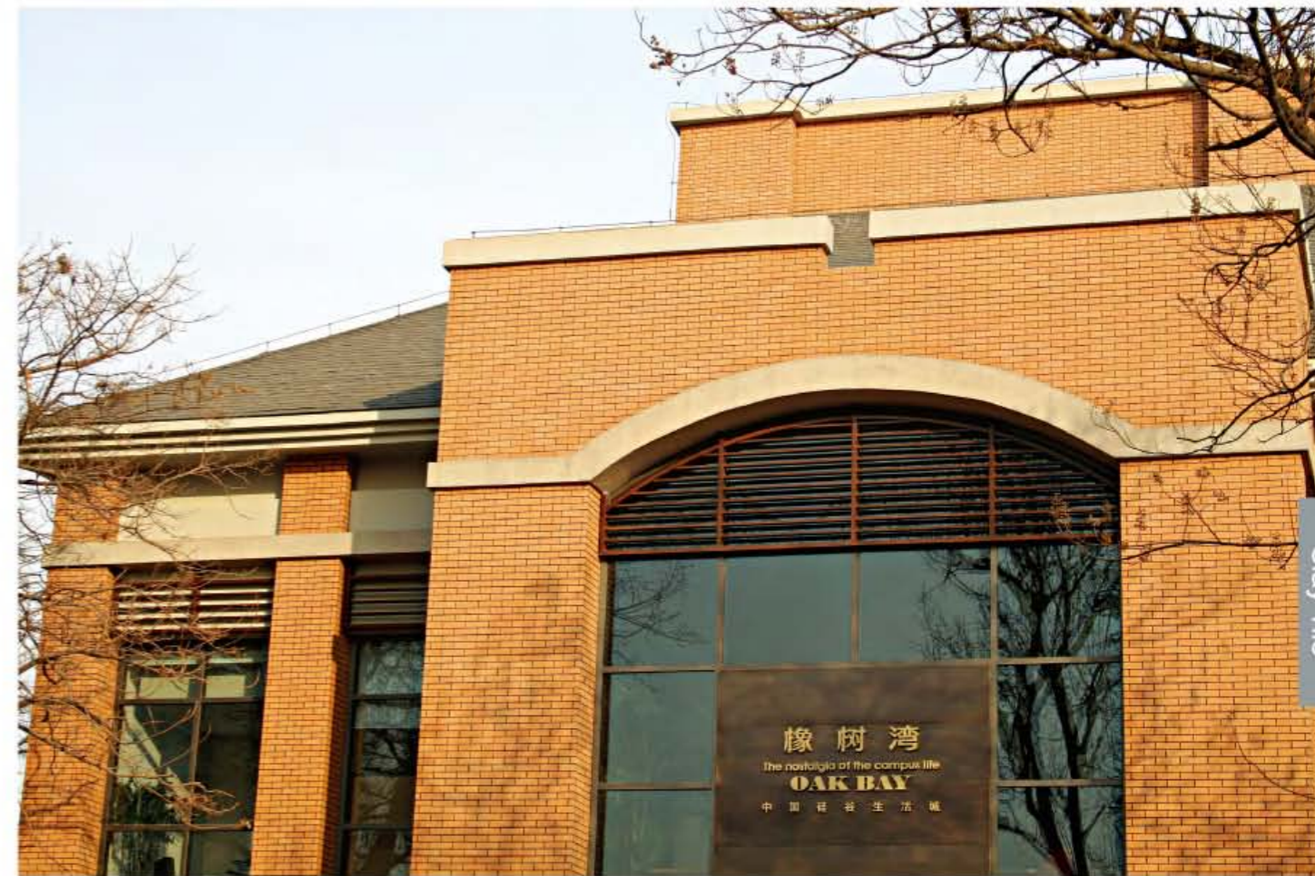
北京市 华润橡树湾 乐普工程实景图
